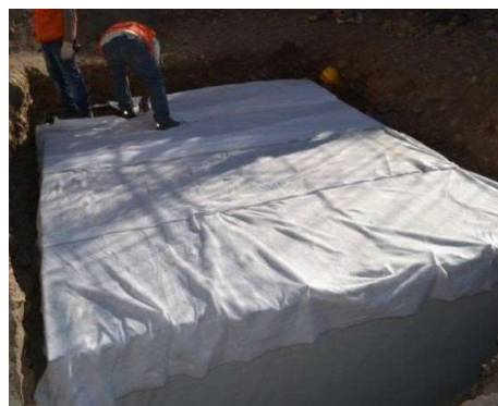
4.- Colocación Geotextil
