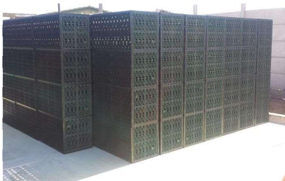
1.- Armado de módulos
