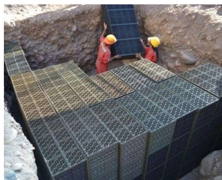
2.- Colocación en la zanja
