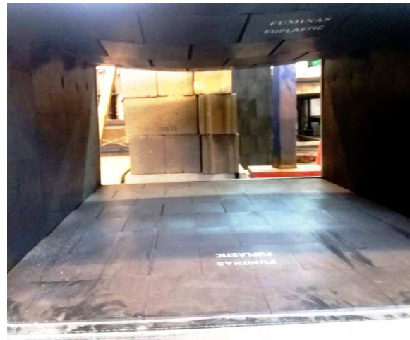
Foto 5: Detalle Deformación de la estructura
